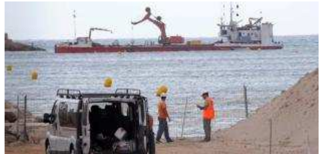
Los trabajos más complicados han sido la colocación de los tubos en el lecho marino. LOIN
