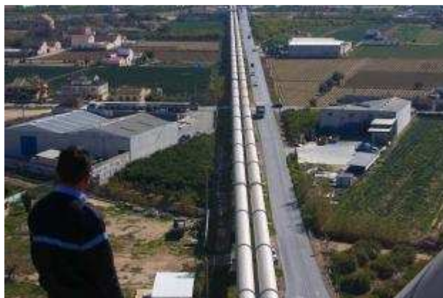
Vista general de las tuberías del trasvase a su paso por el municipio de Orihuela. Antonio amoró:
