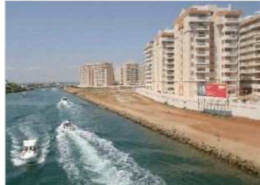
CONSTRUCCIÓN INTENSIVA. Edificios levantados recientemente junto al canal del Estacio, en La Manga del Mar Menor. / PABLO SÁNCHEZ / AGM
