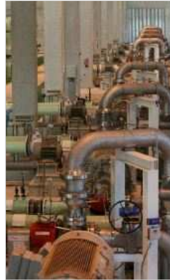
OBRAS. Interior de la desalinizadora Alicante II. / U. ARACIL
