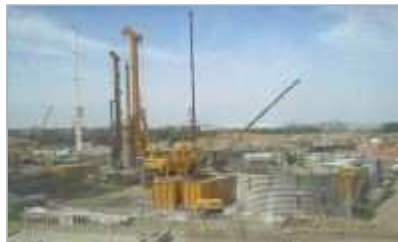
DOS AÑOS DE OBRAS. Estado actual de las obras de la Expo de Zaragoza. Los organizadores trabajan contrarreloj para tener todos los pabellones construidos y preparados para junio del 2008. En la foto, la zona de los pabellones de las comunidades autónomas. / M. BUITRAGO
