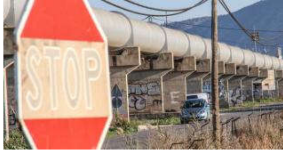
Los tubos del trasvase Tajo-Segura a la altura del Sifón de Orihuela, cuando el agua va camino del Embalse de La Pedrera.
