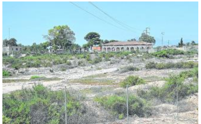
Una imagen de la zona donde se quiere ubicar la planta desaladora. Matías Segarra
