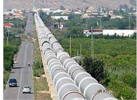
Panorámica de los tubos de conducción del trasvase Tajo-Segura a su paso por la pedanía oriolana de La Aparecida.
