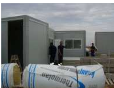
Varios trabajadores ayer en las obras de la nueva planta desalinizadora de Torrevieja.
