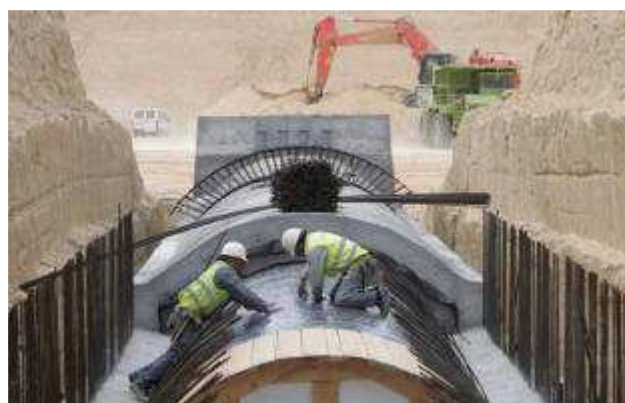
Operarios trabajando en el postravase. Sobre estas líneas embalse de San Diego. DIEGO FOTÓGRAFO
