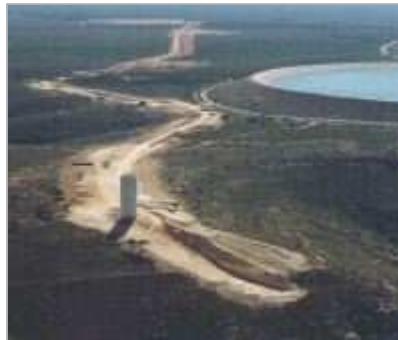
TRASVASE. Obras del nuevo trazado del Júcar-Vinalopó. / L. V.
