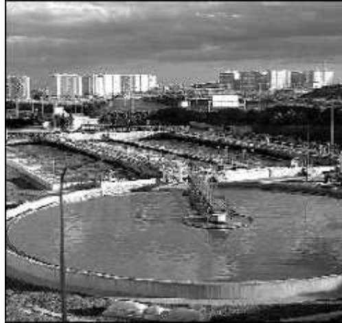
Imagen de archivo de la depuradora de Rincón de León (Alicante)
