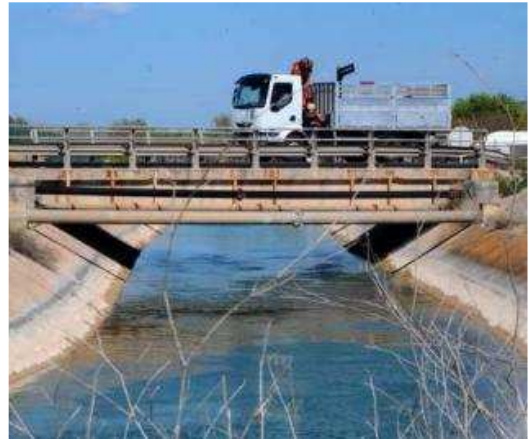
Un camión pasa sobre un canal de riego del trasvase. loino
