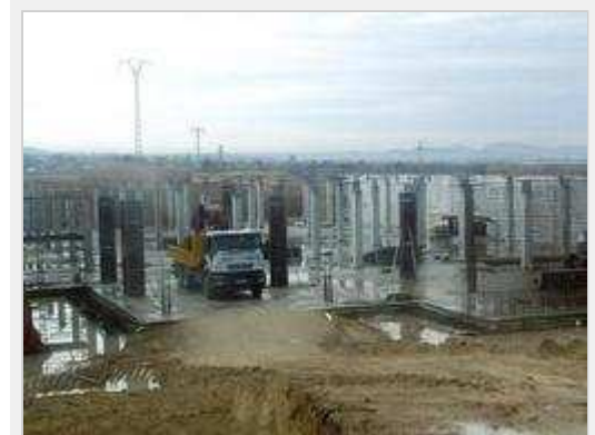
Obras de la desalinizadora de Torrevieja.
