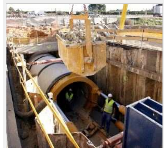
A TOPE. Canal que se construye a la altura de Xàtiva. / L. P.
