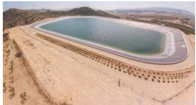
Agua de sobra
