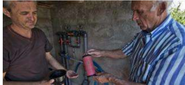
Regantes muestran la suciedad que lleva el agua y que acaba taponando las tuberías del riego por goteo en el Camp d'Elx ANTONIO AMORÓS
