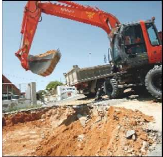
Las obras de ampliación de la desaladora continúan
