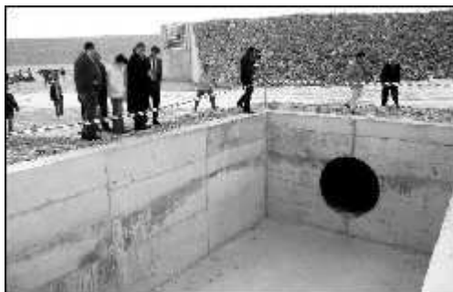
El presidente de la Confederación Hidrográfica del Júcar, Juan José Moragues, inspecciona ayer la infraestructura del embalse junto a la alcaldesa de Villena
