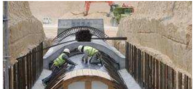
Una pareja de operarios trabaja en una de las canalizaciones de post-trasvase Júcar-Vinalopó por donde se distribuirá el agua que llegue de Cullera. diego foTÓGRAFO!
