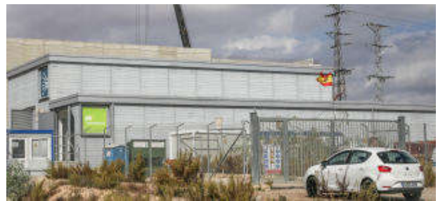
Más del 60% del agua que sale del grifo procede ya de la desalinización del mar
