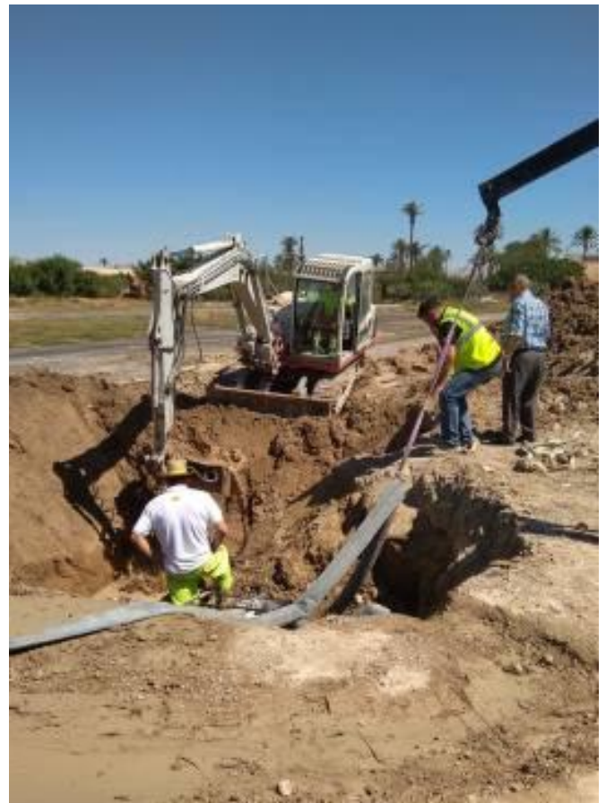
Trabajos para reparar la segunda avería que sufre este año la tubería y que tuvo lugar a mediados de mayo. INFORMACIÓN
