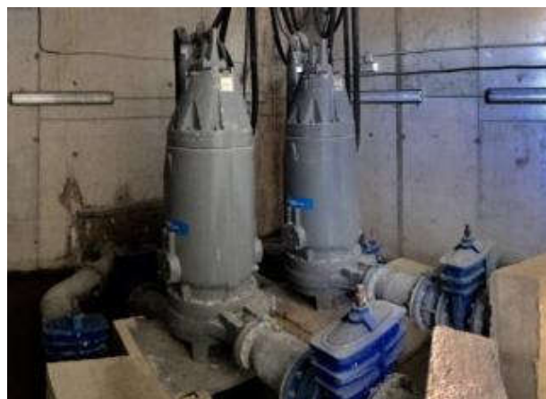
Una de las instalaciones de bombeo por donde pasará el agua depurada. información
