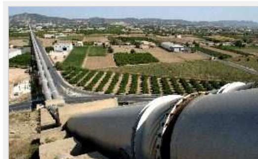
CANAL. Detalle del tubo del acueducto Tajo-Segura, a su paso por la Vega Baja. / L. V.
