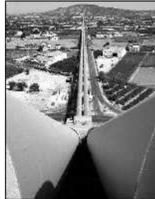
Vista general de las tuberías del Tajo-Segura a su paso por Orihuela
