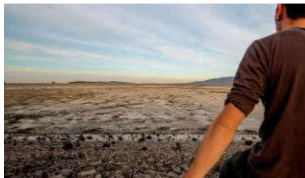
Estado actual que presenta el embalse de San Diego de Villena, obra cumbre del trasvase del Júcar-Vinalopó, que lleva cuatro años construido y sin utilizarse. ÁXEL ÁLVAREZ
