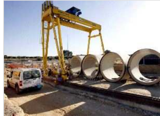
TUBERÍA. Zona de trabajos de la conducción a la altura del término municipal de Rotglà. / L. P.
