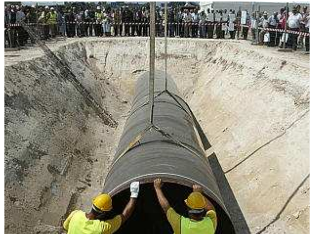
Imagen de las obras del tramo que se conectaría con Tous . pila corTÉ!
