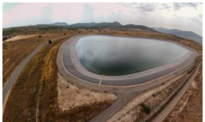
El embalse monovero de El Toscar desde el que partirán los 36 kilómetros de tuberías que distribuirán el agua del Júcar hasta
