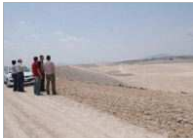
A PUNTO. Técnicos de las constructoras de la balsa de San Diego, donde llegará el agua. / ÁNGEL GARCÍA
