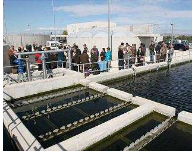
La depuradora de Carrizales ampliará el suministro de agua a la comunidad de regantes DIEGO FOTÓGRAFOS
