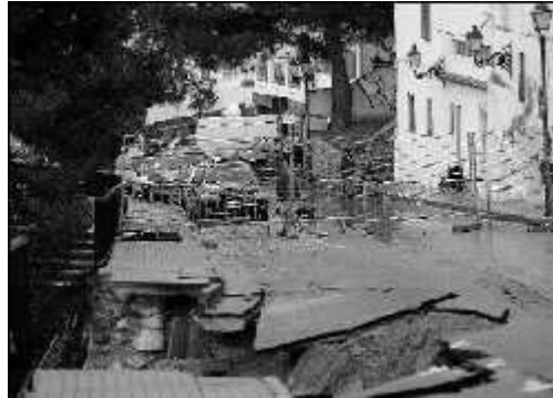
Imagen de la zona afectada por los desprendimientos en la calle Calvario de Altea
