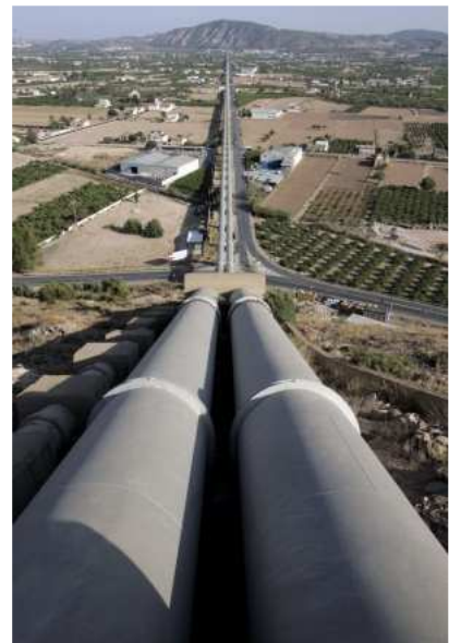
Tuberías de conducción de agua del trasvase Tajo- Segura, a su paso por Orihuela (Alicante). / JOAQUÍN DE HARO
