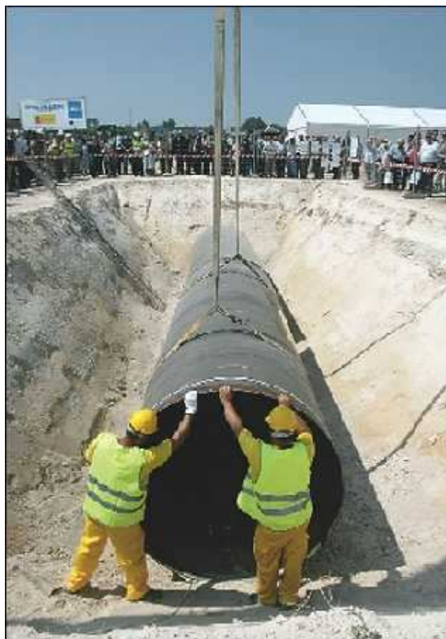
Dos operarios colocan una tubería del tramo «C» en Llanera de Ranes PILAR CORTÉS
