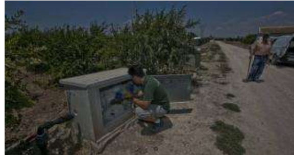
Un vecino observa una caseta en la que se robó un contador de agua, en la zona de La Hoya en Elche. ANTONIO AMORÓS
