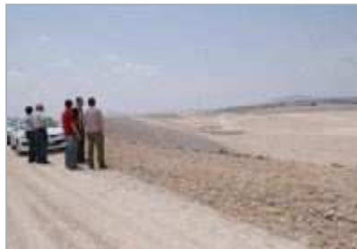
SIN HORMIGÓN. Detalle de las obras, a punto de finalizar, del embalse receptor de las aguas del río Júcar, en Villena. / ÁNGEL GARCÍA
