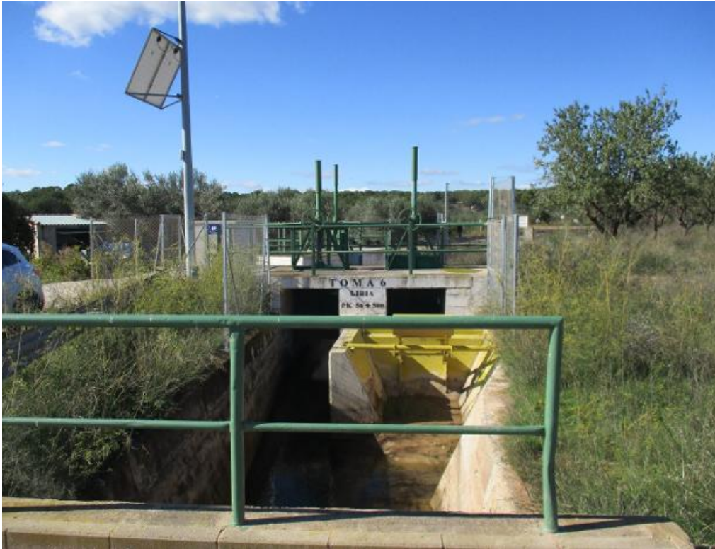
Compuertas de regulación en el canal de Benagéber, que abastece gran parte del riego en el Camp de Turia. / V. LLADRÓ
