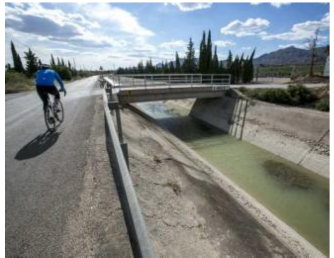
Canal para distribuir el agua del Tajo en el Camp
