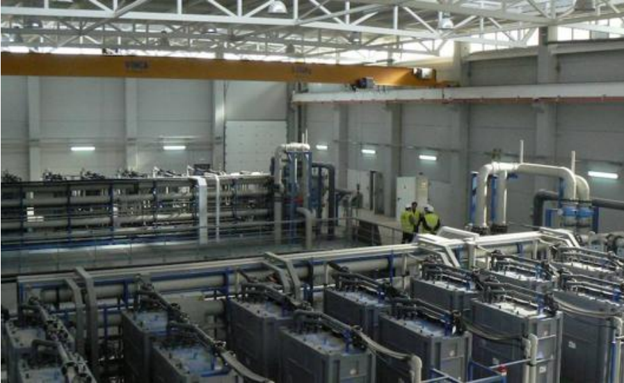
Instalaciones de la desnitrificadora de l'Eliana. /
