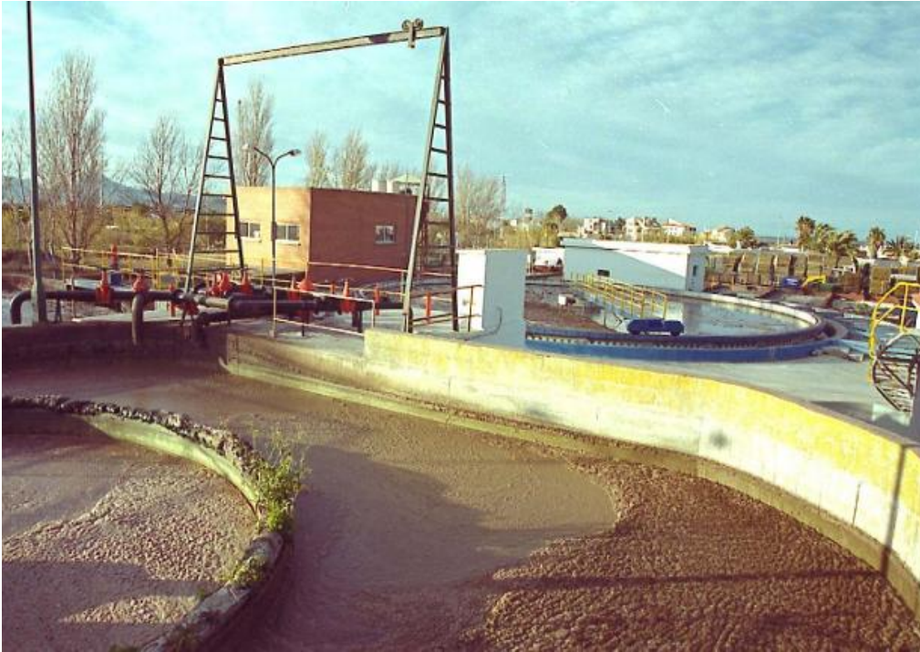
Estación depuradora de aguas residuales de Oliva. /
