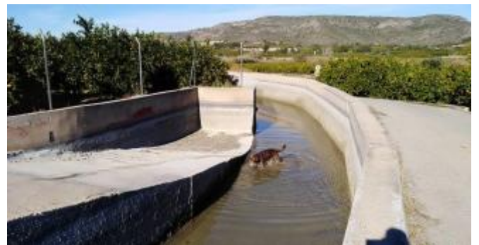
Una imagen de la Real Acequia Escalona a su paso por Sumacàrcer el pasado invierno antes de la suelta de aguas para el riego de emergencia. f. j. g.
