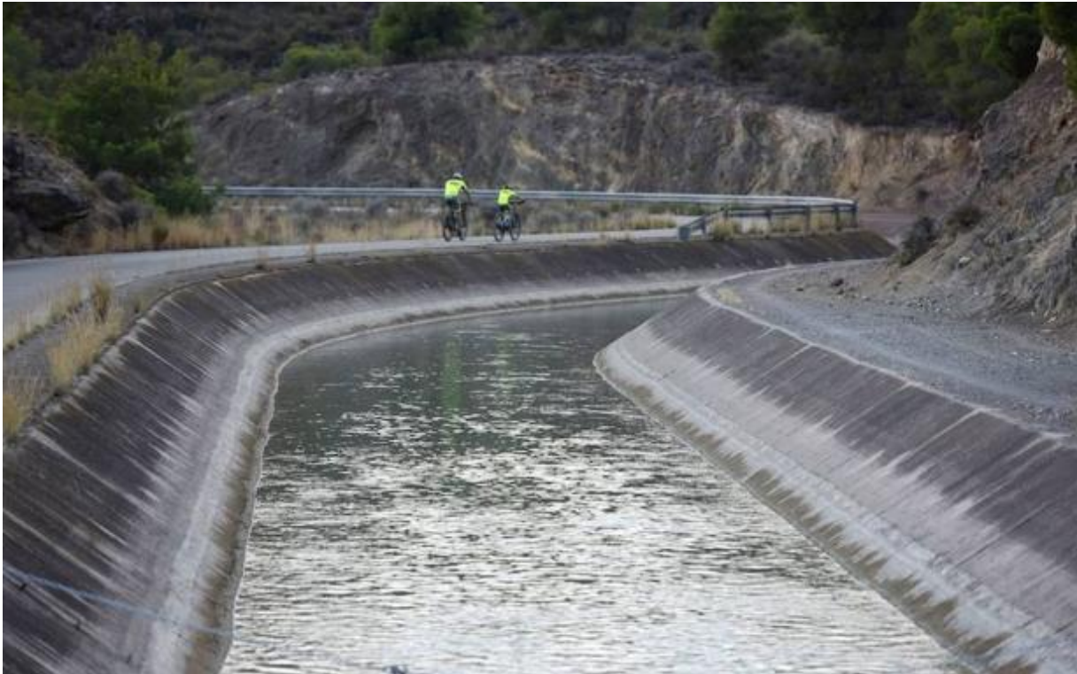
Cauce del trasvase Tajo-Segura, a su paso por Sierra Espuña. /
