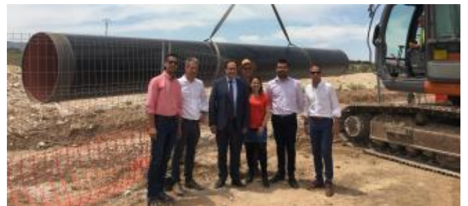
Los alcaldes con el conseller visitando las obras del tramo
