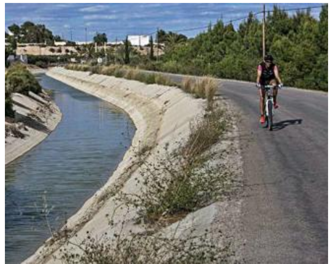
Canales para el reparto del agua del trasvase en el Campo de
