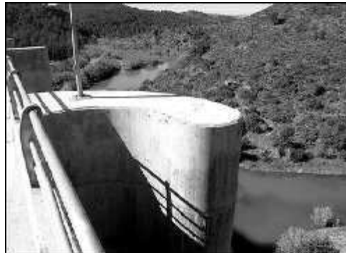
en Activo. Primeros caudales retenidos en la presa del Algar tras la colocación de las compuertas.
