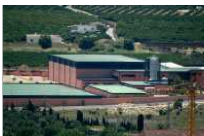
Planta desalinizadora de Xàbia, proyecto que se inauguró en 2002 con el gobierno del Partido Popular.
