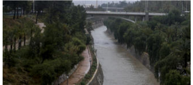
Cs insta a la Confederación del Júcar a realizar mantenimiento del cauce del Vinalopó y limpiar los barrancos de Elche
