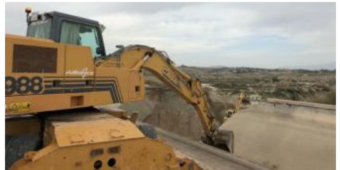
La Confederación del Segura inicia las obras para reparar los canales del trasvase Tajo-Segura
