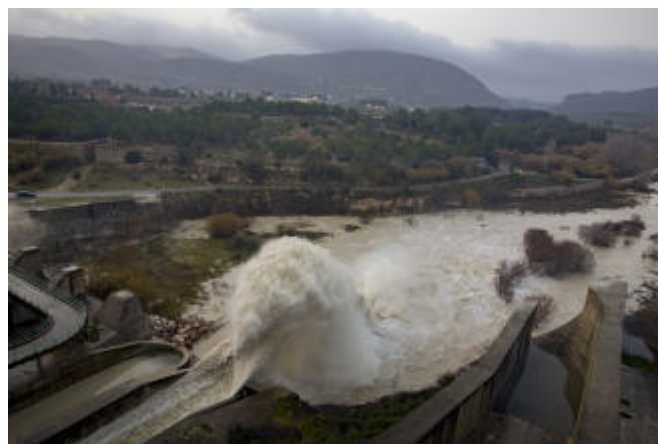
Desembalse controlado en Bellús durante el temporal del pasado enero que provocó inundaciones en la Ribera. perales iborra
