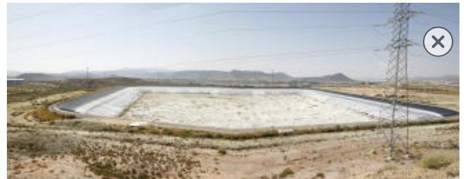
El Gobierno tramita, ocho años después de que se detectaran las fugas, la reparación del embalse para regular el Júcar-Vinalopó
